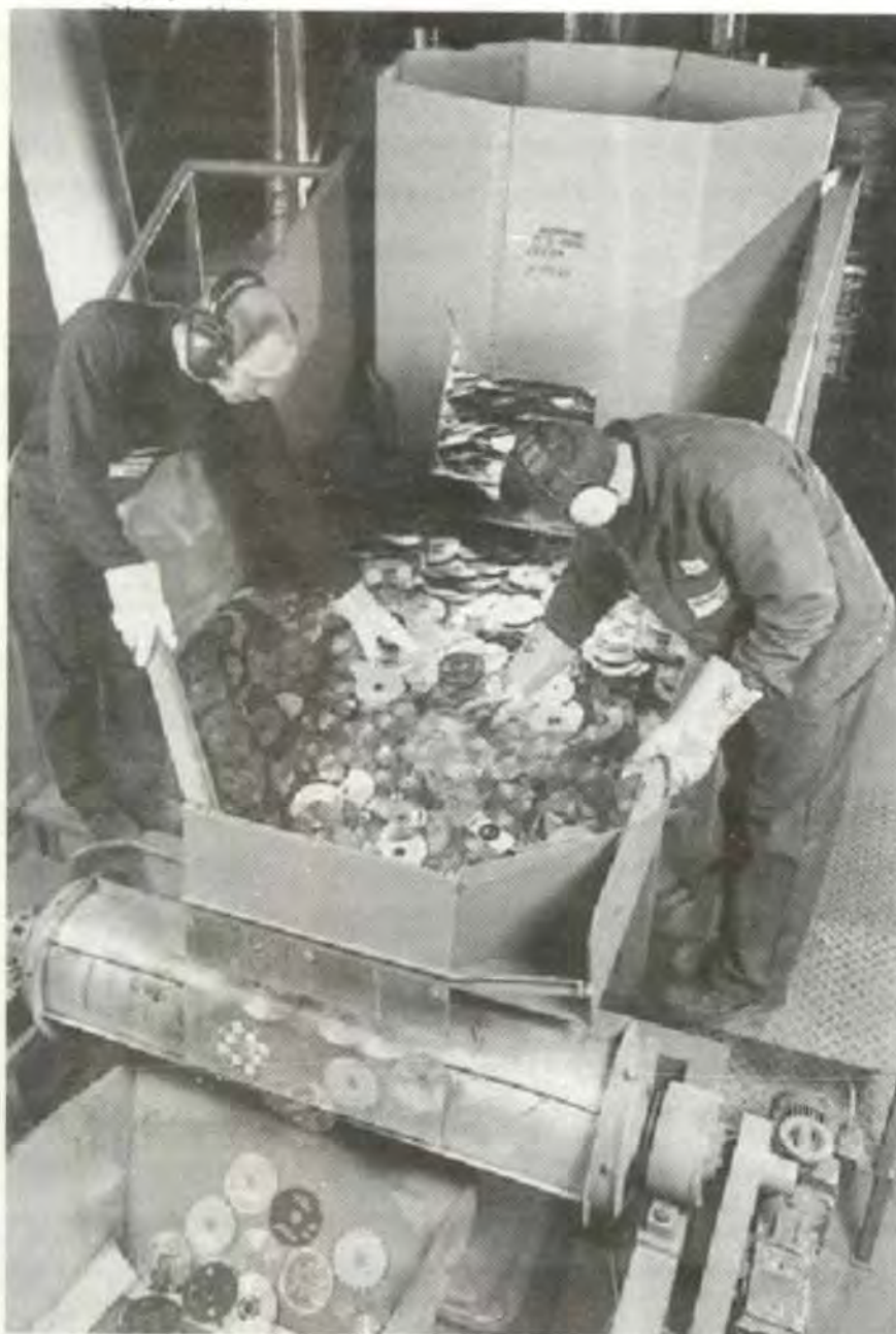
Figura 3. Los contaminantes se separan manualmente antes de que el material del CD se pase a través de un separador de metales.
