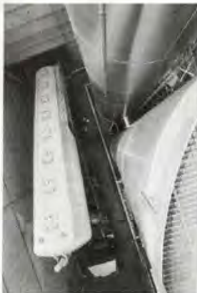
Figura 4. Cargando un silo con material reciclado en la planta de Bayer en Dormagen.
