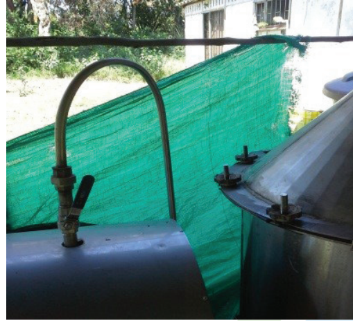
Imagen 14. Tubo conductor de vapor con problemas de fuga – necesidades de mantenimiento y soldadura - Driver steam pipe leakage problems - maintenance and welding needs
