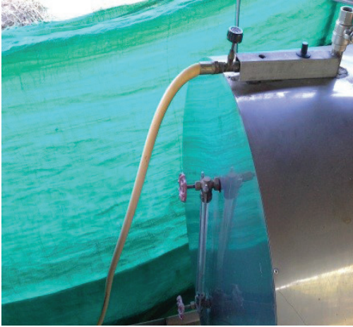
Imagen 13. Válvula manual - falta de mantenimiento y con requerimientos de ser automatizados - Manual valve - lack of maintenance and automation needs
