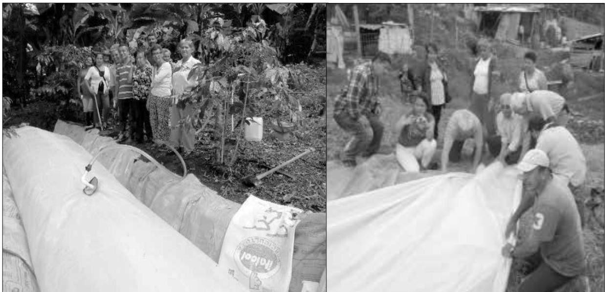
Foto 1. Aprendices en el proceso de instalación. Fuente: Elaboración propia.
