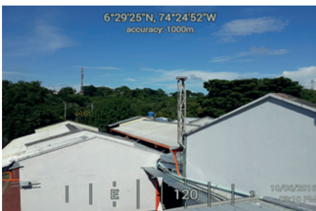
Imagen 3. Antena GPS Puerto Berrio – Antioquia (Fotografía propias del Centro de formación).
