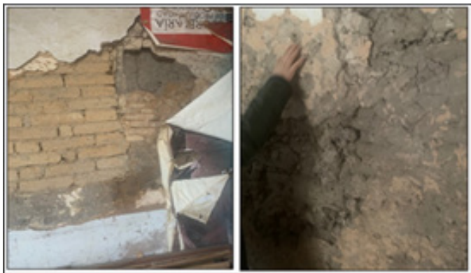
Imágen 2 Muros en bloque de tierra comprimida y en tapia, vistos en el claustro de Santa Clara la Real.
