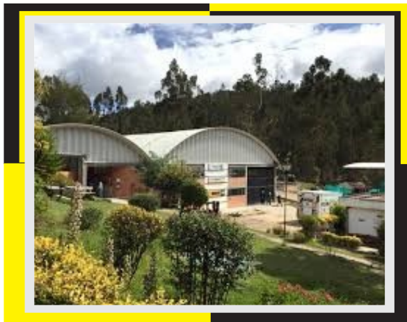
Figura 2. Edificio ABC, Centro minero, 2014 Fuente: SENA
