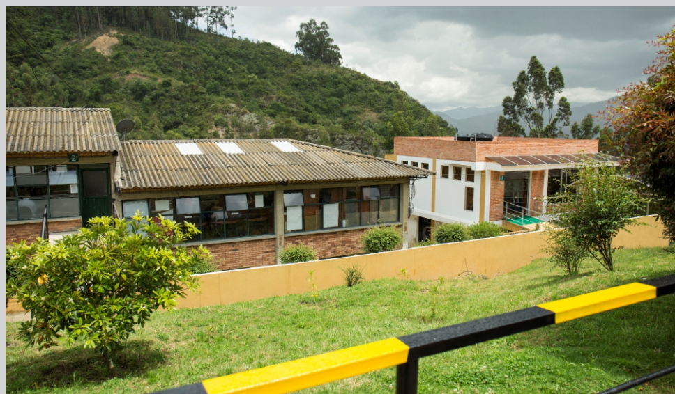
Instalaciones SENA Regional Boyacá - Centro Minero Fuente: SENA
