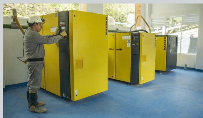
Formación en Montaje Electromecánico de Instalaciones Mineras Bajo Tierra SENA Regional Boyacá - Centro Minero Fuente: SENA
