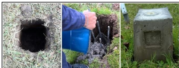
Figura 1. Instalación de un vértice geodésico: excavación, refuerzo y concreto.
