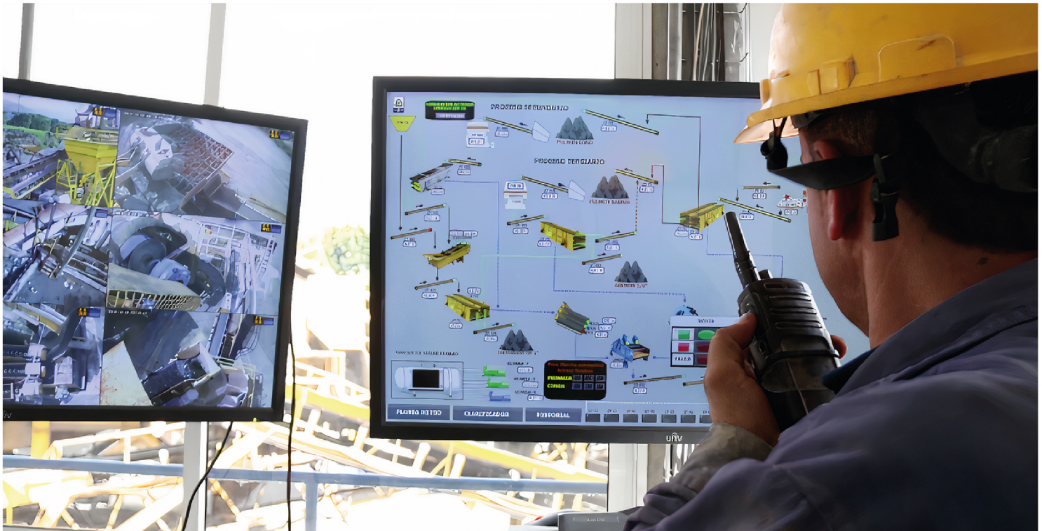
Figura 4. CCTV en sala de control. Fuente propia
