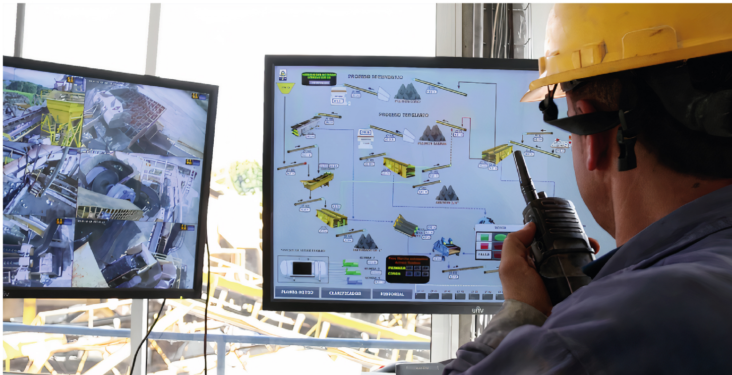
Figura 4. CCTV en sala de control. Fuente propia
