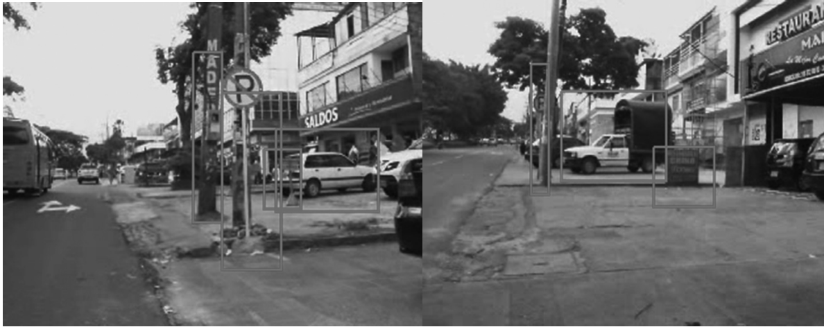
Figura 1. Obstáculos fuera del alcance del bastón, postes situados en medio del andén sin cumplir la reglamentación establecida y vehículos mal ubicados
