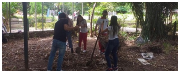
Figura 1. Adecuación de terreno
