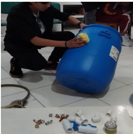
Figura 3. Instalación de válvulas y tubería en el biodigester.
