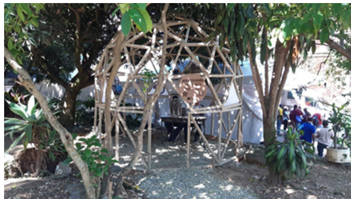
Figura 9. Construcción del Domo Geodésico Fuente: Elaboración propia
