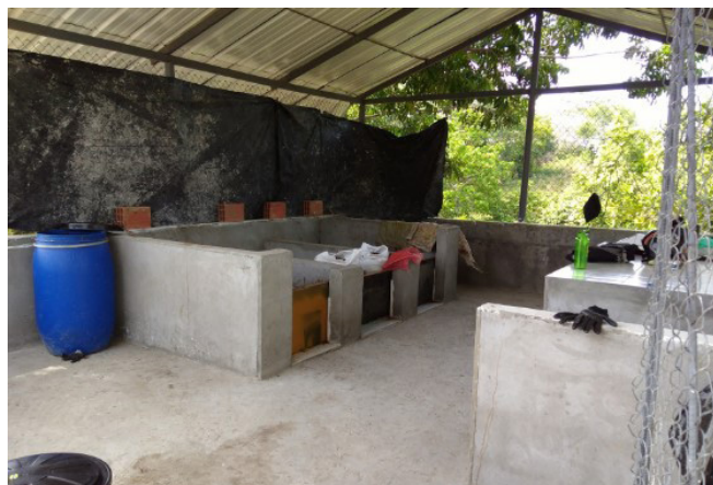
Figura 2. Interior de la planta de compostaje
