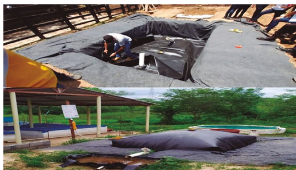
Figura 5. Área de construcción del biodigestor.
