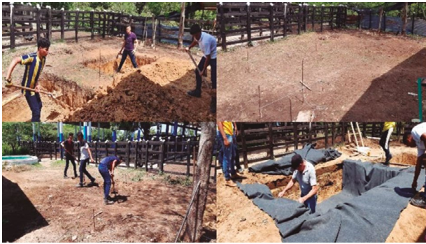
Figura 3. Procesos constructivos del biodigestor.
