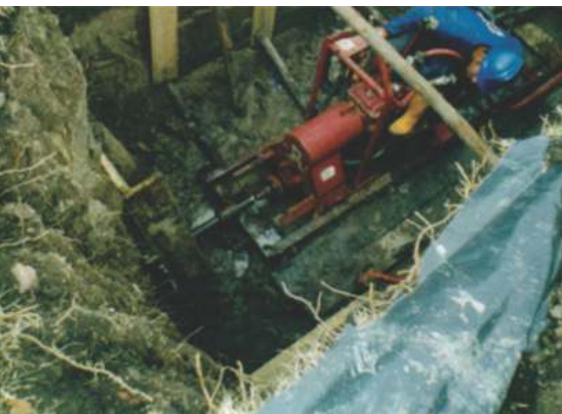
Imagen 3. Operación de equipo de excavación sin Zanja Fuente: foto suministrada por William Montaña
