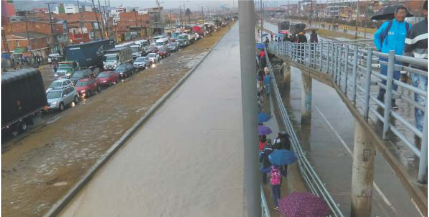
Figura 5: Inundación de las vías de Transmilenio
