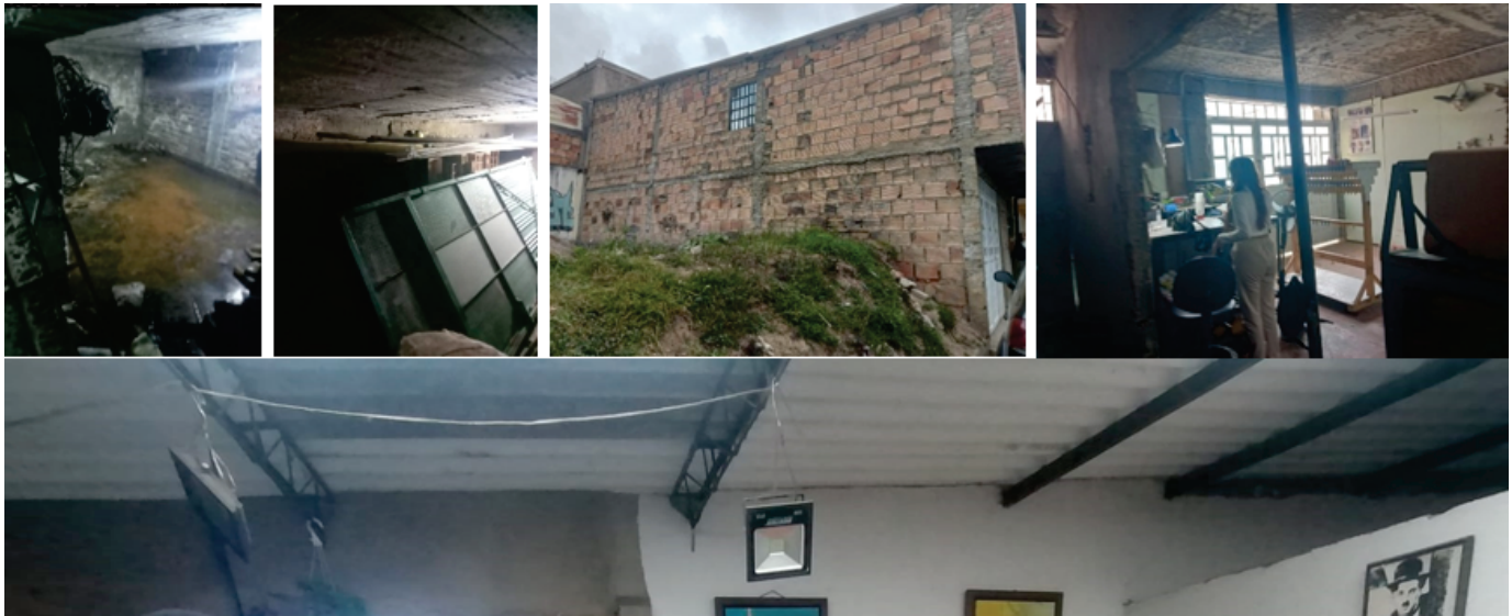
Figura 5. Estado actual de la vivienda.
