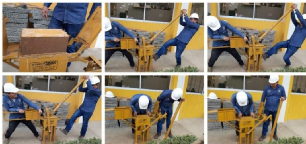
Figura 13. Elaboración de BTC, resultado final para construcción de muro de prueba.
