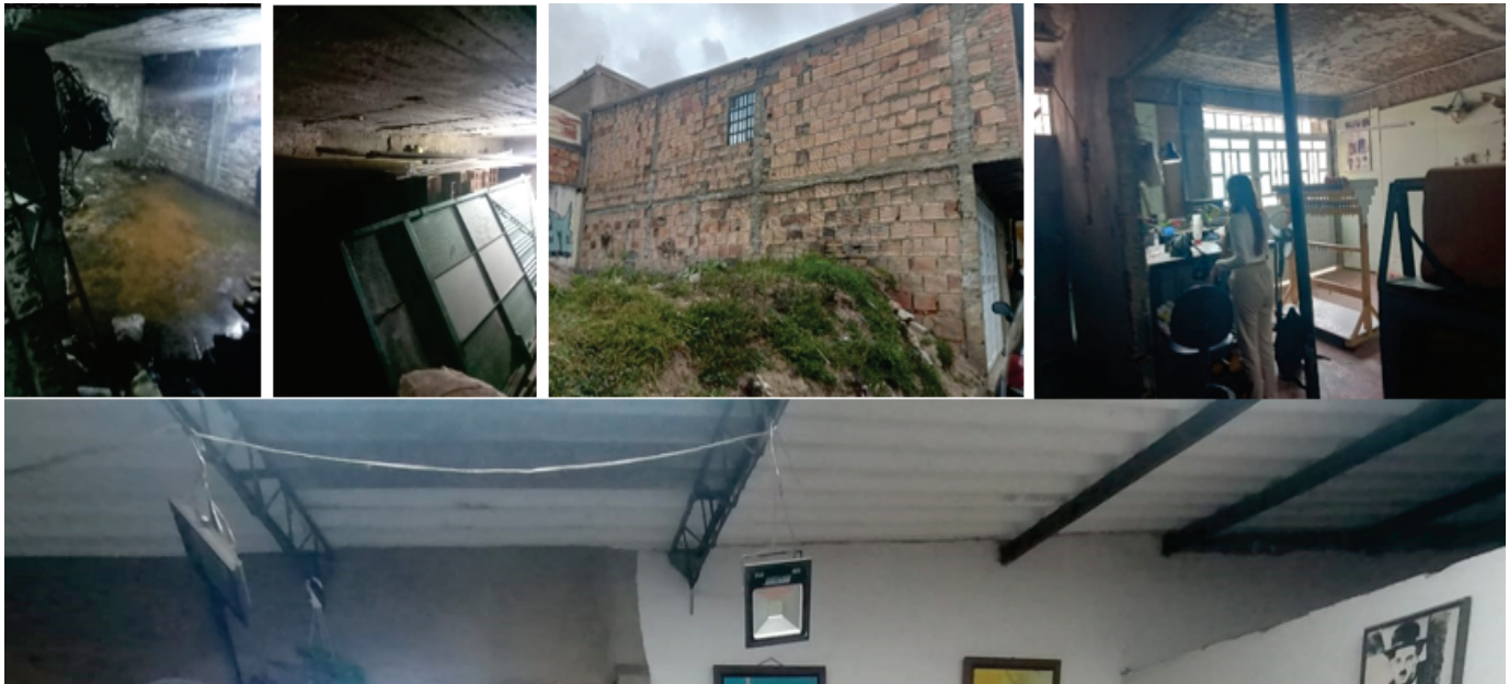
Figura 5. Estado actual de la vivienda.
