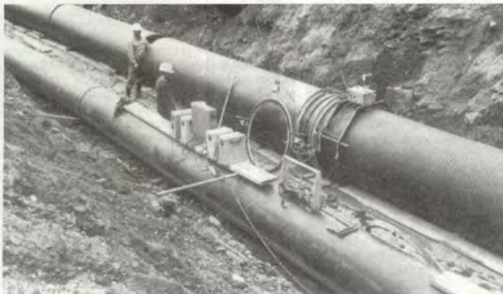
Fig. 4 Soldadura a campo abierto de un tubo de PE (cortesía: Hoechst Corp.)
