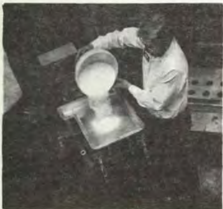
Figura 2. Llenado del molde.
