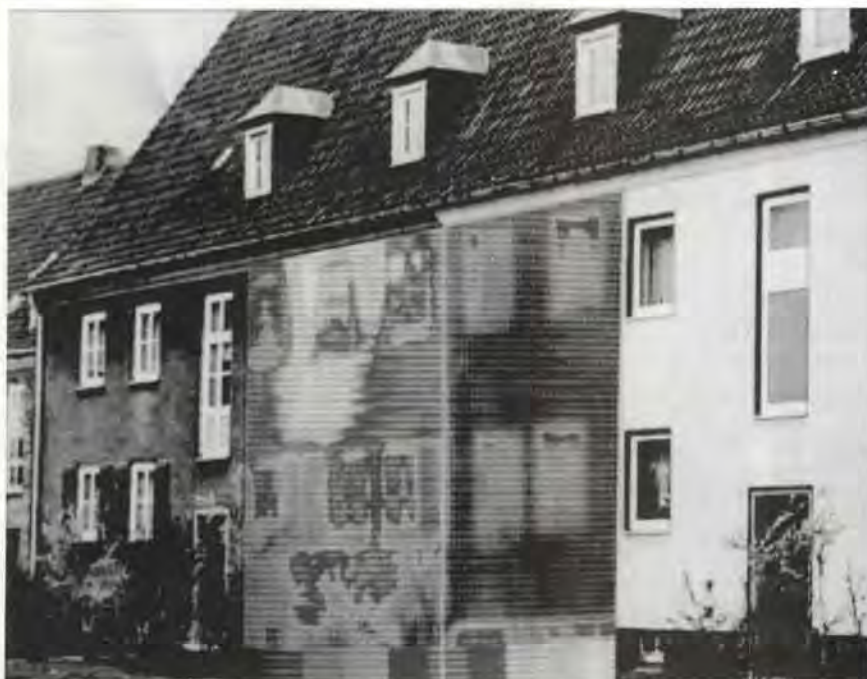
Medición de la radiación térmica de una pared sin aislación (izquierda) y con aislación (derecha) con una cámara infrarroja
