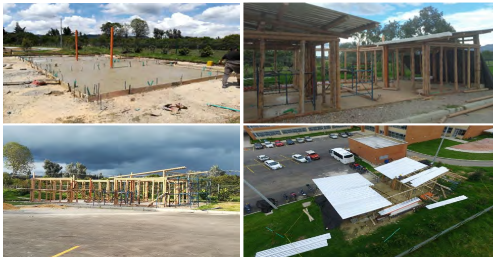
Figura 5. Proceso Constructivo Vivienda ECO Sostenible.
