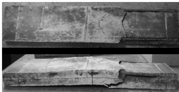
Figura 4. Falla frágil del panel reforzado con varilla sin mallas. Fuente: Los autores
