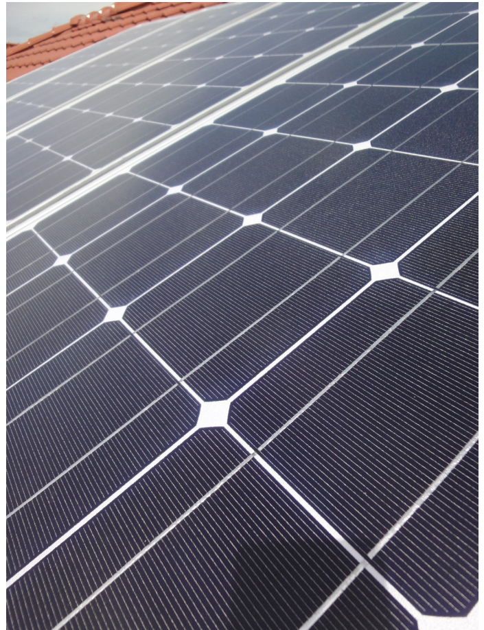
Figura 3: El silicio policristalino es fácil de reconocer por su color negro oscuro
