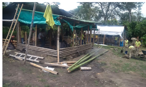
Ilustración 1. Adecuación de instalaciones.
