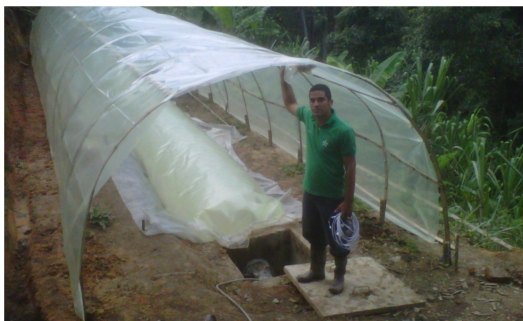
Figura 2. Biodigestor tubular de polipropileno tipo Taiwán cubierto con techo tipo camión.
