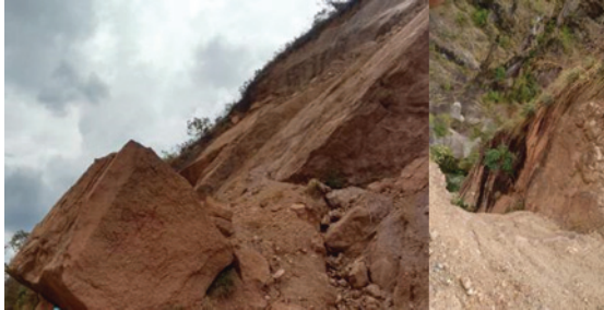
Figura 15. Zona degradada estación 12
