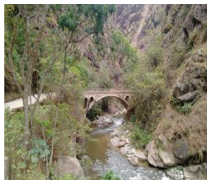
Figura 14. Zona degradada estación 11
