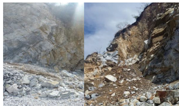
Figura 17. Zona degradada estación 14
