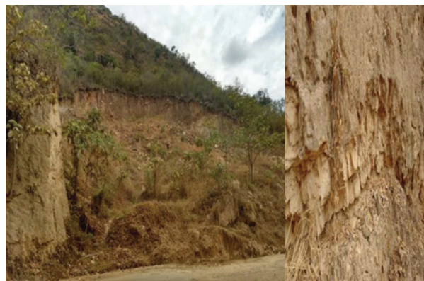
Figura 7. Zona degradada estación 4.
