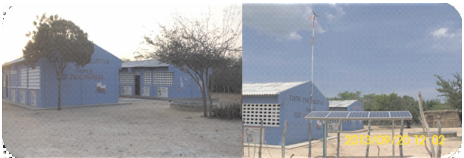
Figura 5. Sistema híbrido instalado, antes y después.
