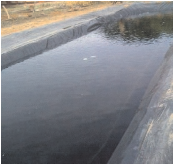
Figura 3. Sistema de captación de agua (acequia a reservorio). Fuente: Elaboración propia (2014).
