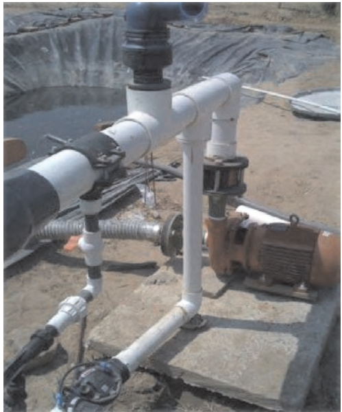
Figura 2. Modelo de cabezal de riego utilizado para el prototipo de automatización de riego.
