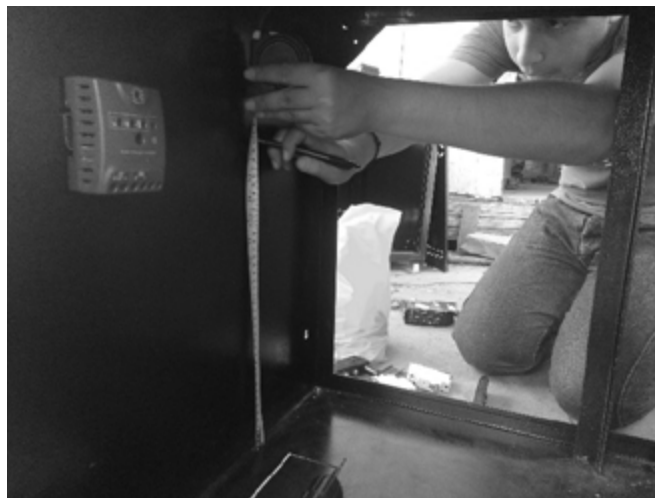
Figura 1. Aprendiz ejecutando el primer procedimiento de instalación de un SFVA. Fuente: los autores.
