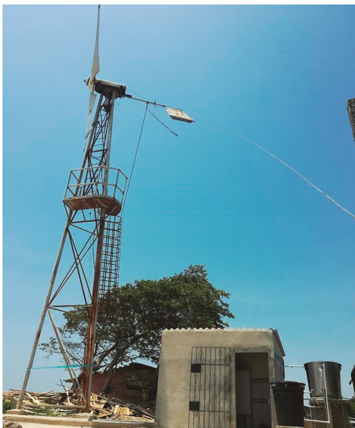
Figura 5. Sistema de desalinización instalado
