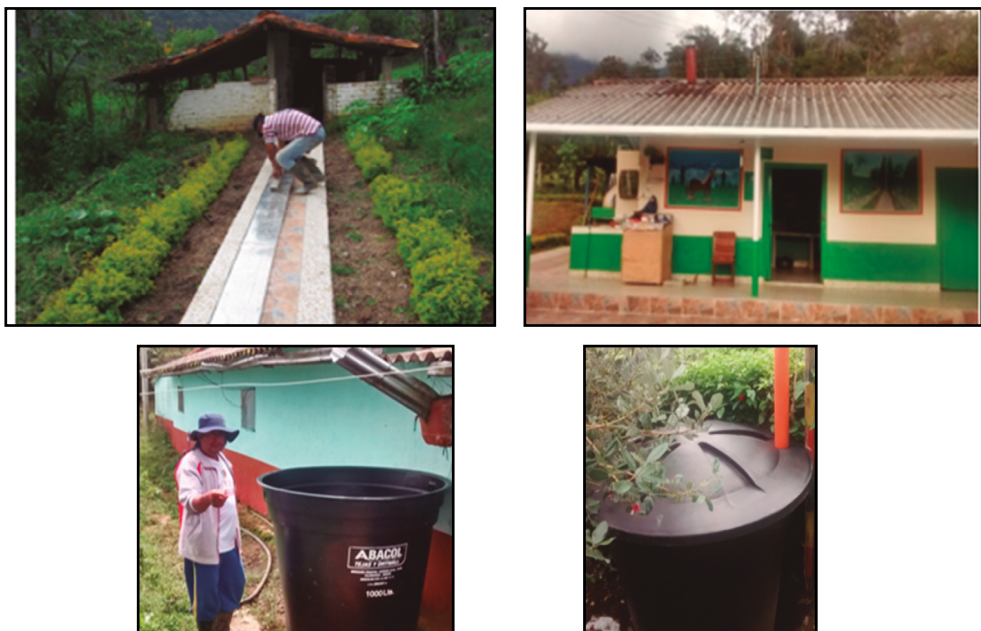
Figura 4. Proceso de construcción sistema de cosecha de aguas lluvias
