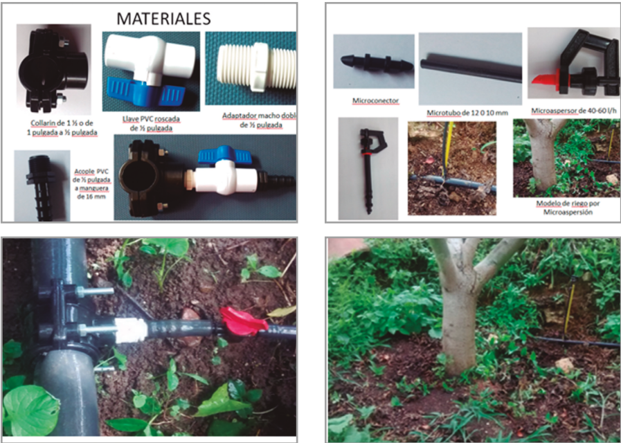
Figura 3. Proceso de Construcción sistema de riego
