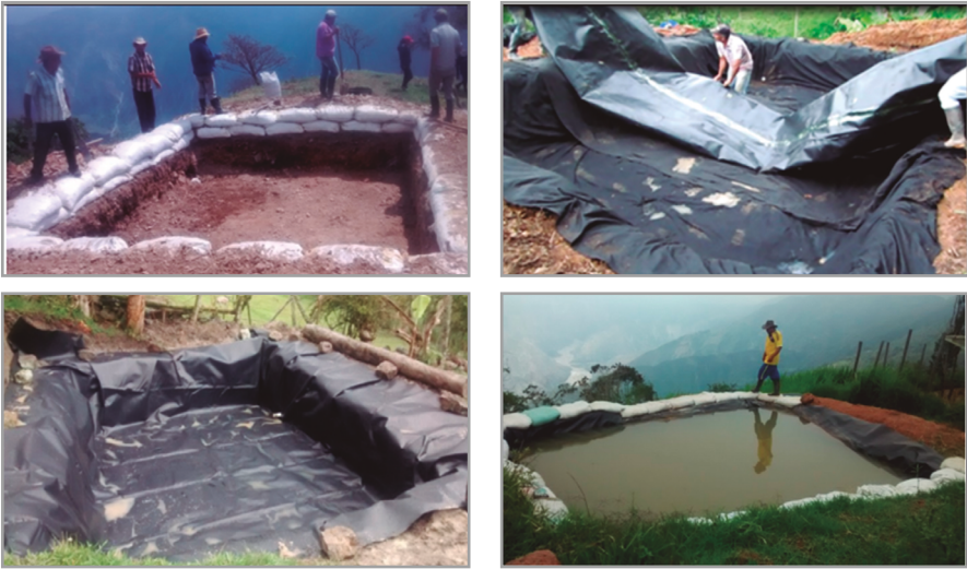
Figura 2. Proceso de Construcción reservorios de 20000 litros
