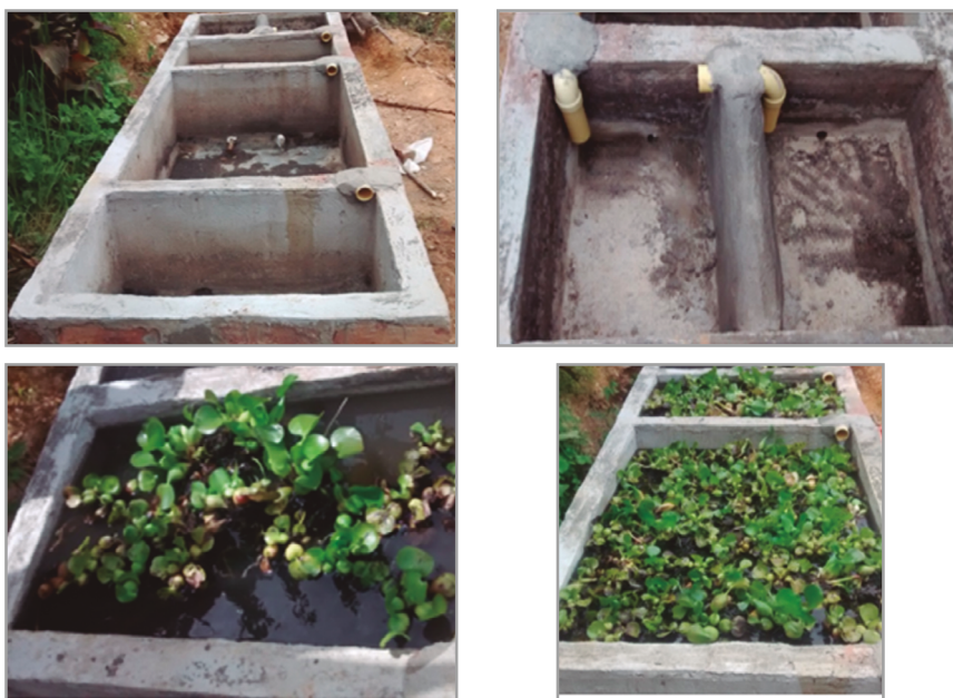
Figura 5. Proceso de construcción sistema de reciclaje de aguas grises
