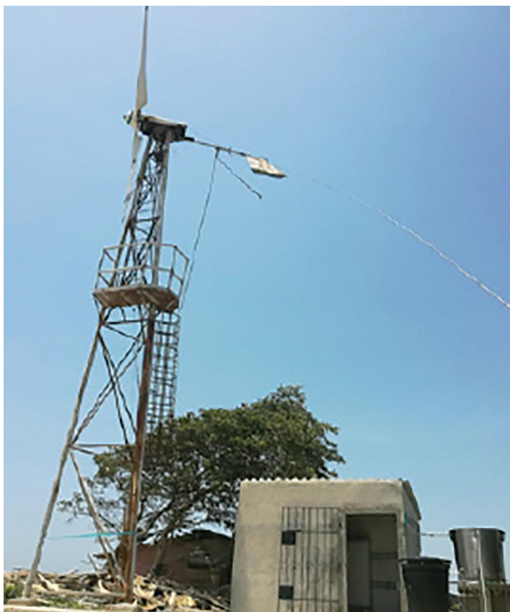
Figura 5. Sistema de desalinización instalado
