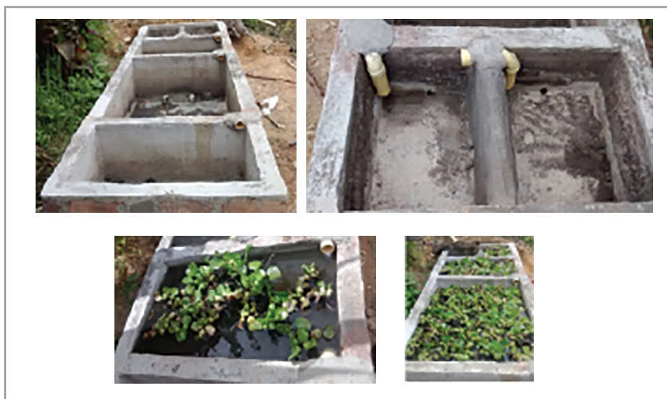
Figura 5. Proceso de construcción sistema de reciclaje de aguas grises
