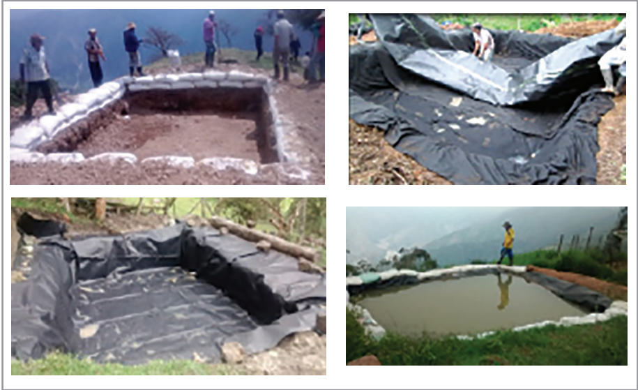
Figura 2. Proceso de Construcción reservorios de 20000 litros
